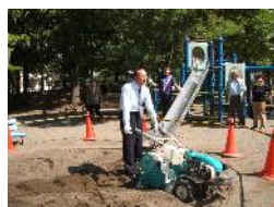
【 砂場清掃機稼働中 】
